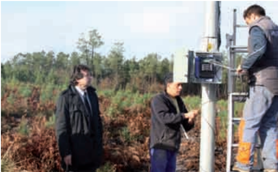
Pose du mât de mesure
