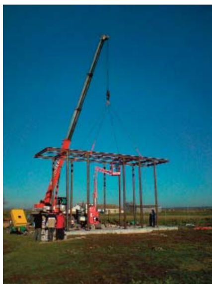
Une tour d'observation de 10 mètres de haut avec vue sur les marais
