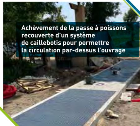
Achèvement de la passe à poissons recouverte d'un système de caillebotis pour permettre la circulation par-dessus l'ouvrage
