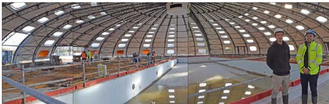
À l'intérieur ne reste plus que le bassin principal. À droite, Étienne Bilhère, secrétaire général à la mairie de Braud, et Nicolas Combret, directeur des travaux pour le groupement d'entreprises Seg Fayat pour lequel intervient 3 bureaux d'études en coordination avec le cabinet d'architecte Moon Safari.
