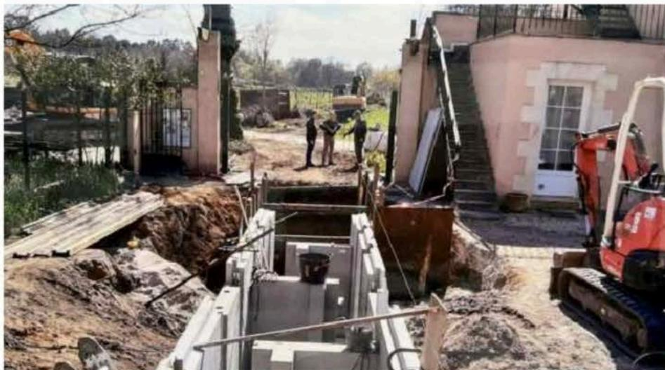
Il a fallu manœuvrer délicatement pour placer les passes à 2,5 mètres de profondeur sans fragiliser les bâtis existants.
