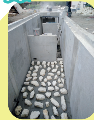
Ouvrage en cours de construction
