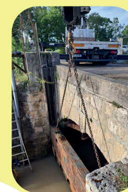
Retrait des anciennes vannes
