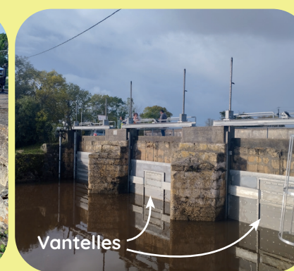
Ouvrage du Passage après travaux.
